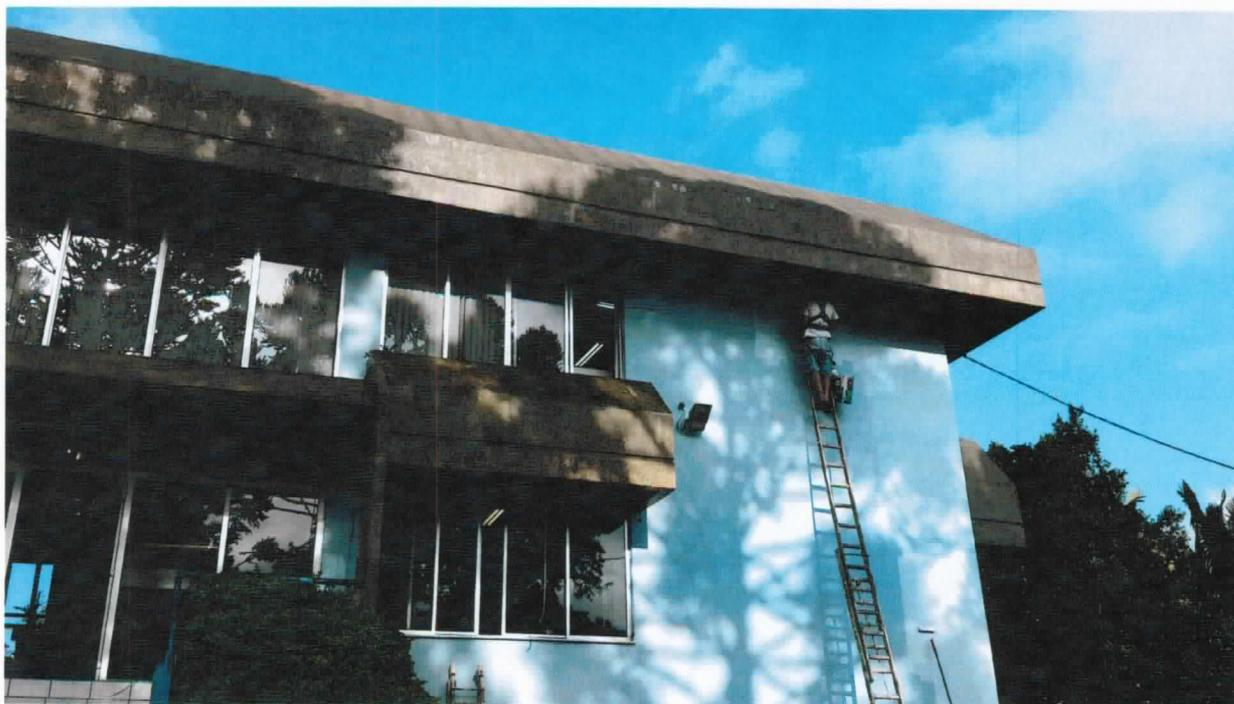
Para tentar contornar, e continuar com o aspecto de concreto aparente, foi produzida tinta com pigmentos cinza e verde, para tentar manter o mesmo aspecto, conforme imagem da tabela de cores ao lado da textura de concreto aparente não danificada pelas intemperes.
