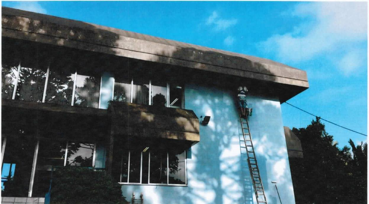
Para tentar contornar, e continuar com o aspecto de concreto aparente, foi produzida tinta com pigmentos cinza e verde, para tentar manter o mesmo aspecto, conforme imagem da tabela de cores ao lado da textura de concreto aparente não danificada pelas intemperes.
